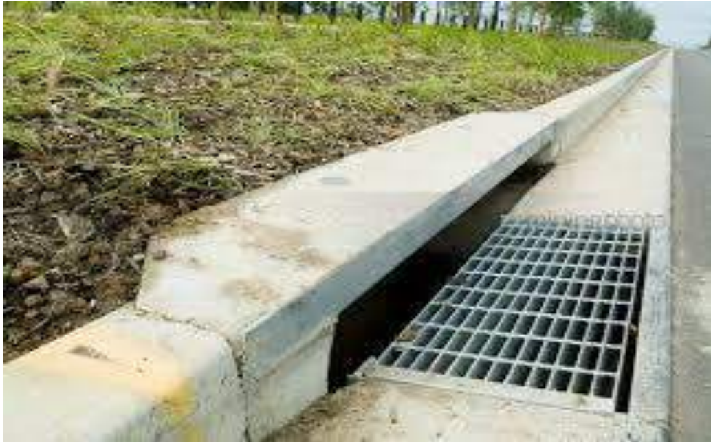
Gambar 2.5 : Saluran Air limbah Tertutup dengan manhole Sumber : https://www.google.com/search?q=gambar+saluran+limbah
