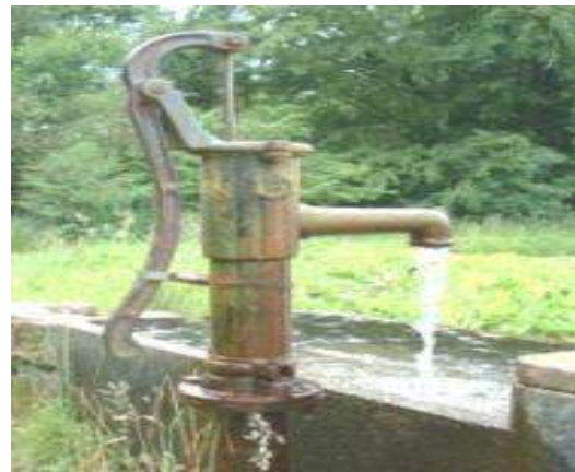
Sumur gali dengan pompa tangan
