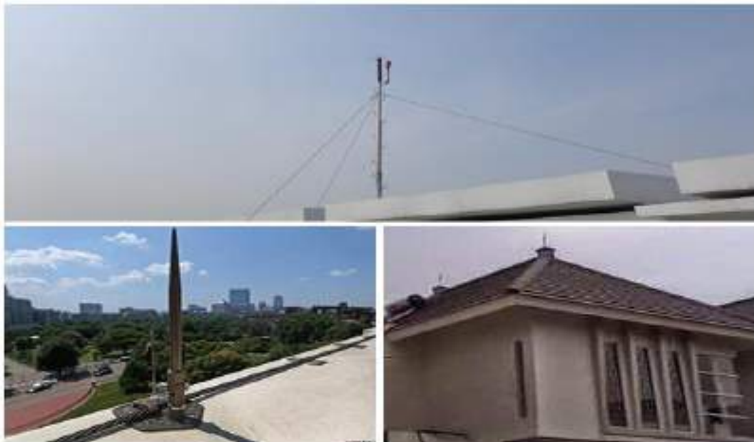
Gambar 1.44 : Atap dengan Penangkal Petir
