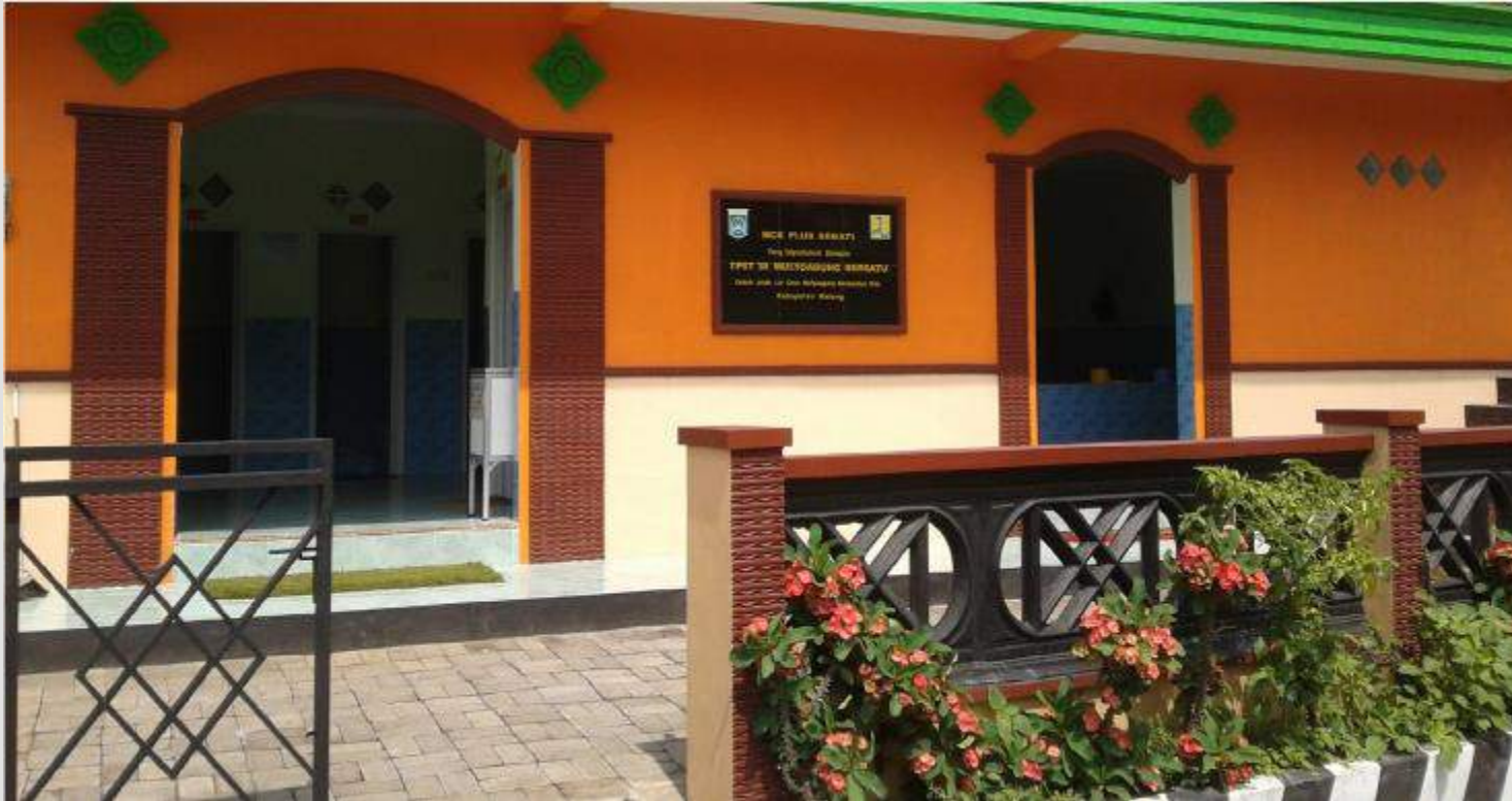
Pembangunan Sarana Air Bersih dan Sanitasi pada TPS 3R Mulyoagung (2012) Kabupaten Malang, Jawa Timur
