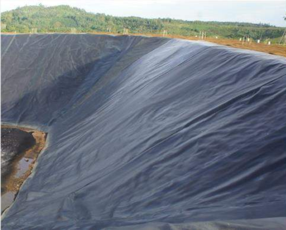
Pembangunan Lapisan Geomembran pada TPA Belau (2013) Kabupaten Kutai Barat, Kalimantan Timur
