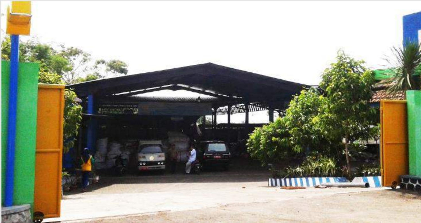
Pembangunan Area Penerimaan pada TPS 3R Mulyoagung (2012) Kabupaten Malang, Jawa Timur
