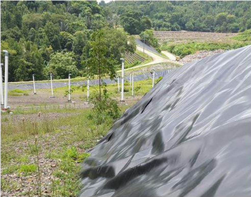
Pembangunan Lapisan Geomembran pada TPA
