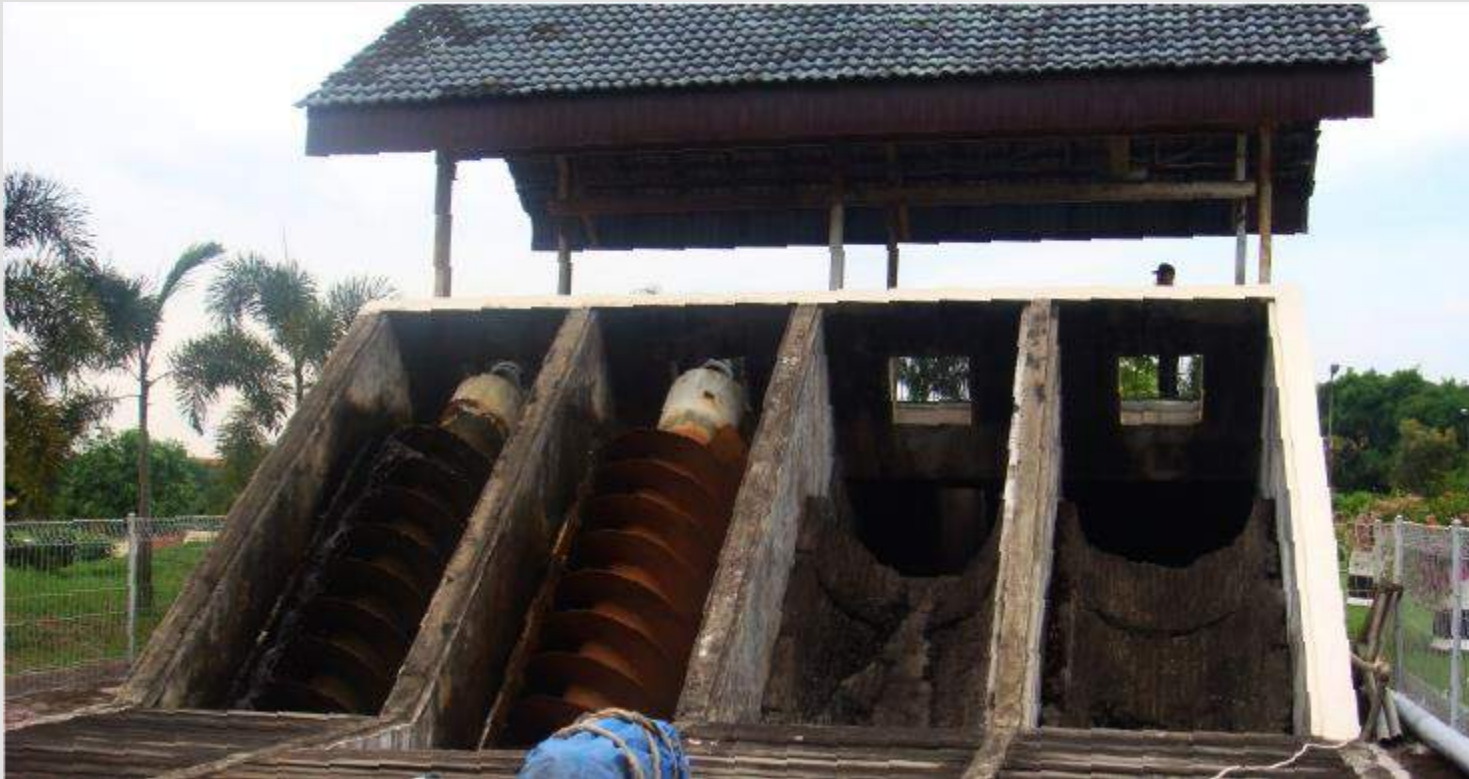
Pembangunan Unit Pompa pada PS Air Limbah Terpusat
