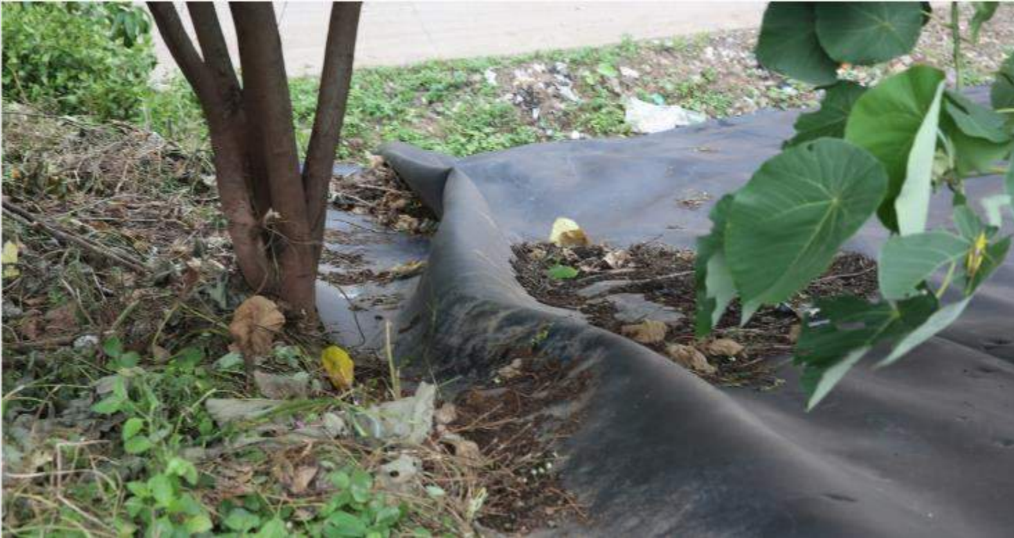
Pembangunan Lapisan Geomembran pada TPA
