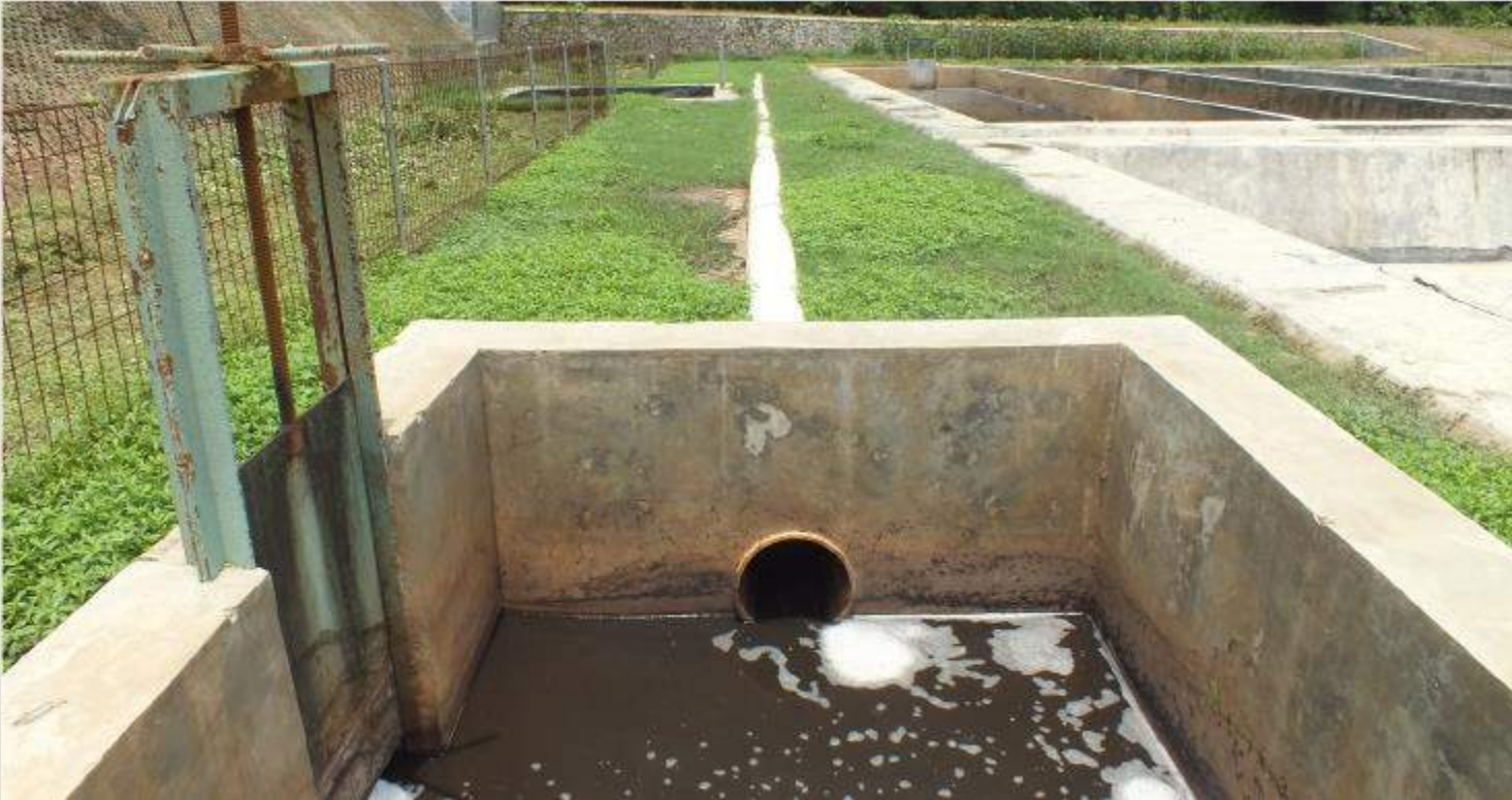
Pemasangan Pipa Instalasi Pengolahan Air Lindi pada TPA
