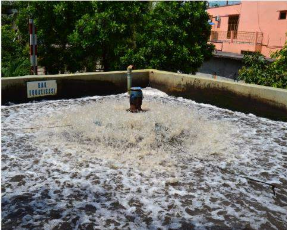
Pembangunan Kolam Aerasi pada PS Air Limbah Terpusat
