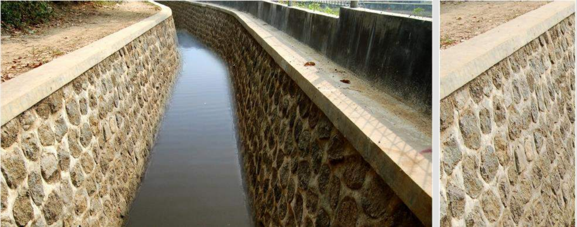
Pasangan Batu Kali pada Drainase Permukiman Kabupaten Bekasi, Jawa Barat
