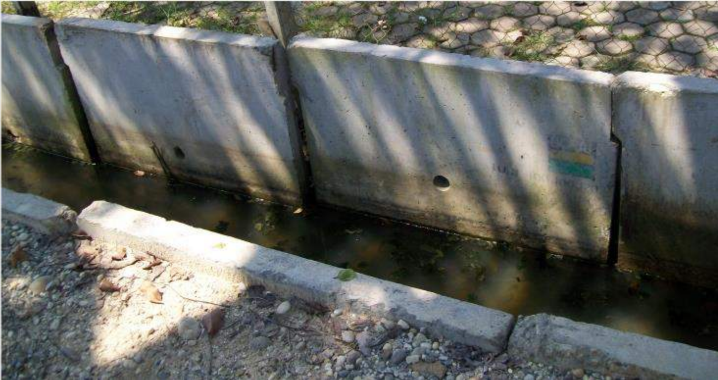
Pasangan Pracetak pada Drainase Perkotaan
