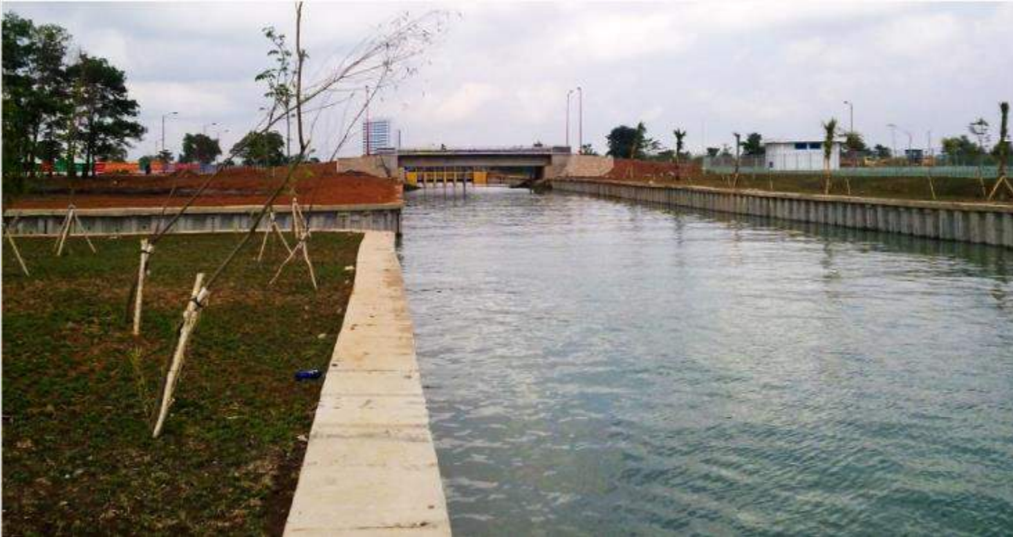
Pasangan Pracetak pada Drainase Primer Jakabaring (2011) Kota Palembang, Sumatera Selatan
