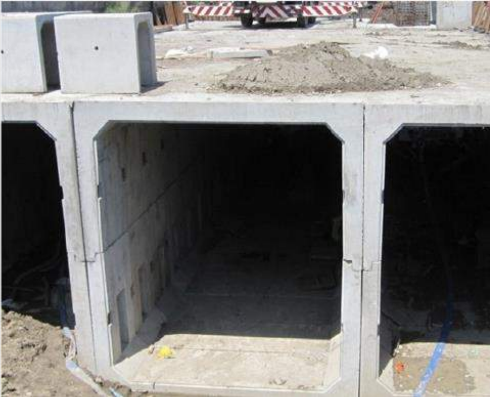
Pembangunan Gorong-gorong pada Saluran Drainase Gunung Sari (2011) Kota Surabaya, Jawa Timur
