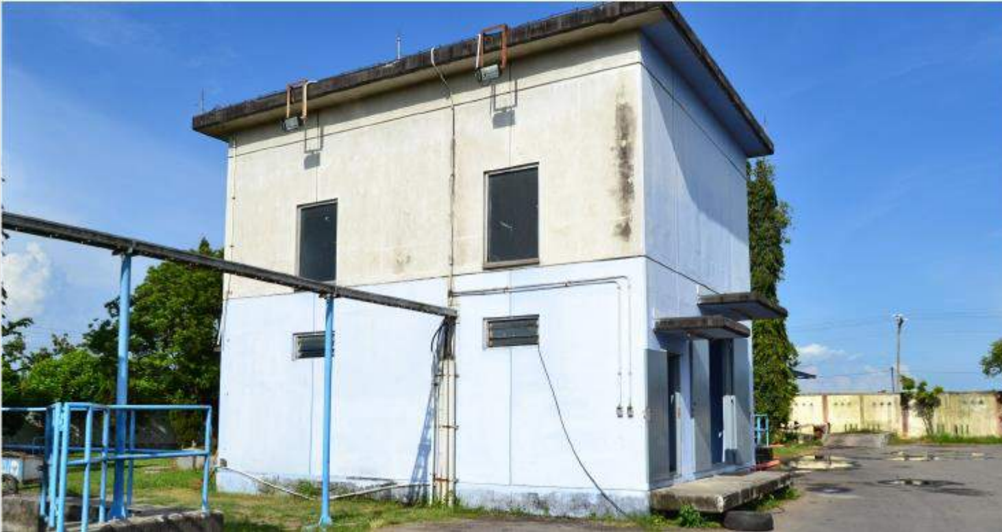
Pembangunan Panel Listrik pada PS Air Limbah Terpusat (2007) Kabupaten Bantul, DI Yogyakarta
