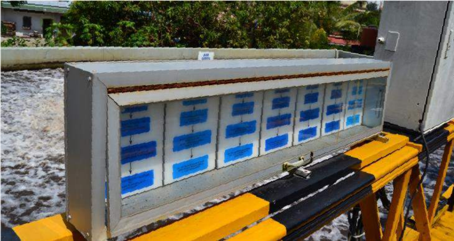
Pembangunan Panel Listrik pada PS Air Limbah Terpusat
