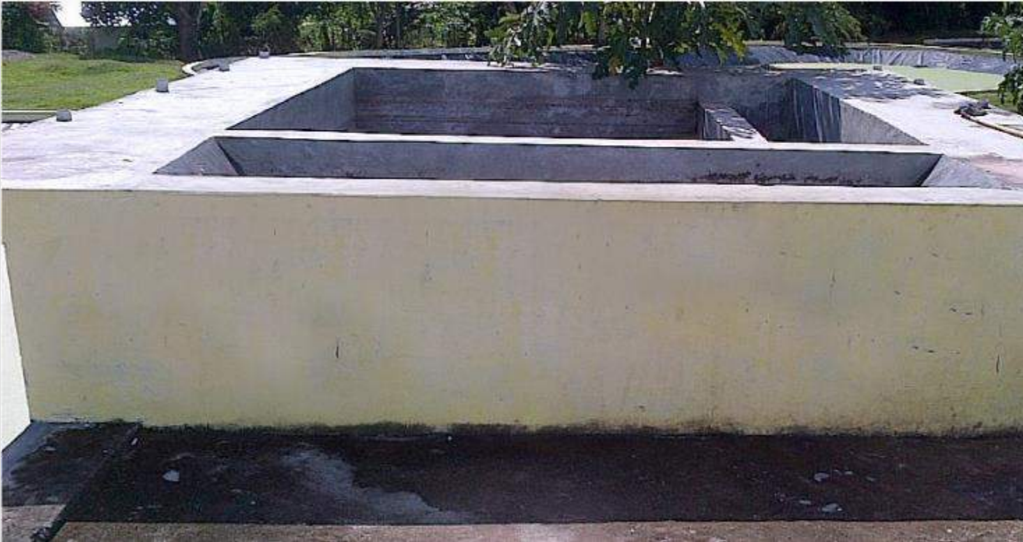
Pembangunan Bak Pengumpul pada IPLT
