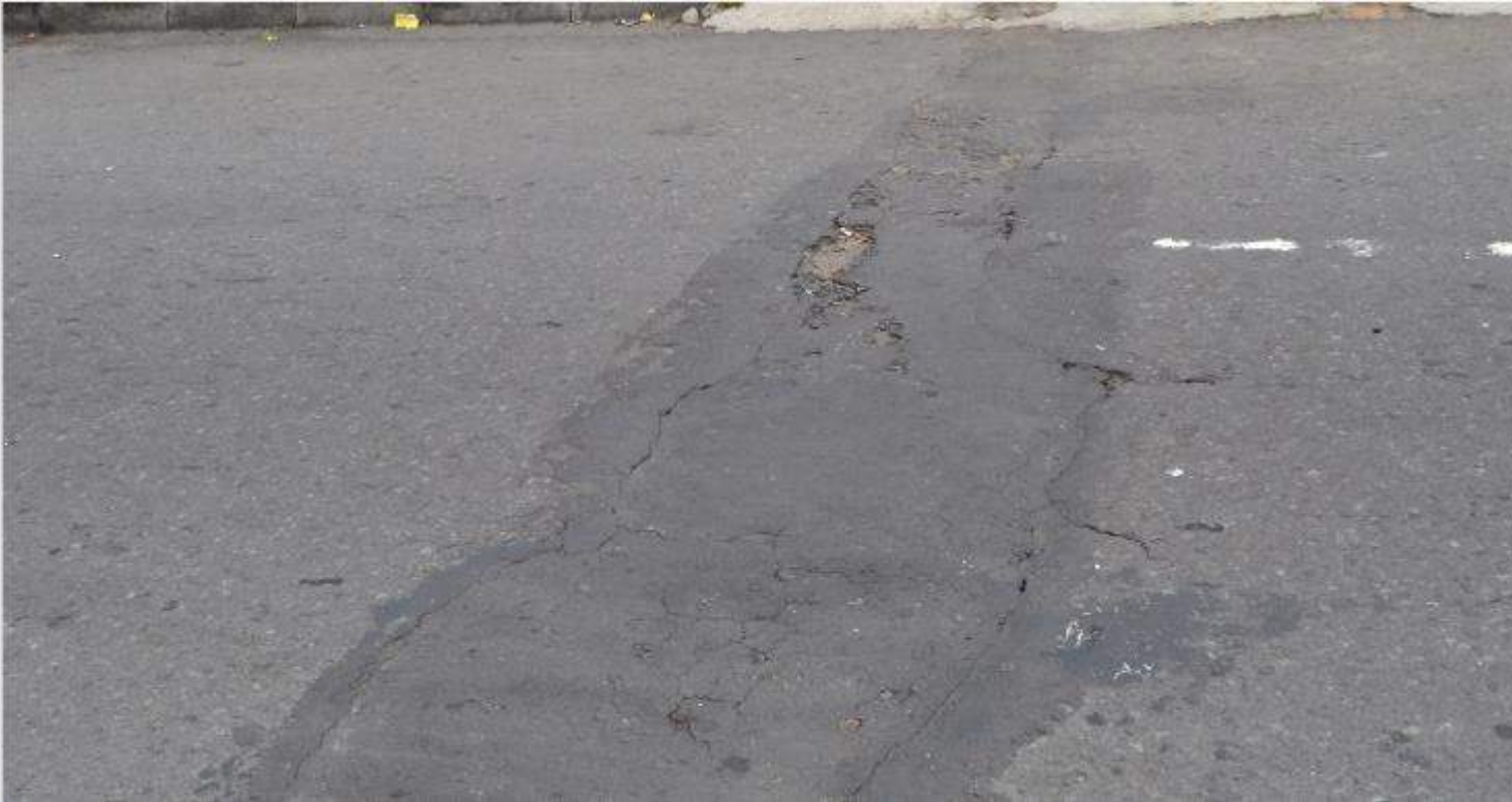
Penutupan Jaringan Perpipaan pada Pembangunan Jaringan Perpipaan Air Limbah
