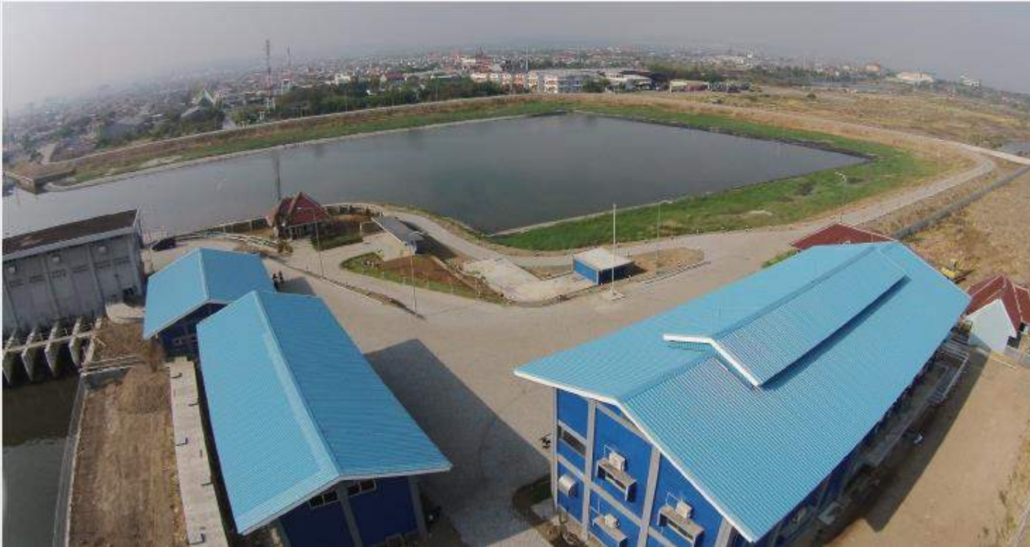
Pembangunan Kolam Retensi pada Stasiun Pompa Kali Semarang (2013) Kota Semarang, Jawa Tengah
