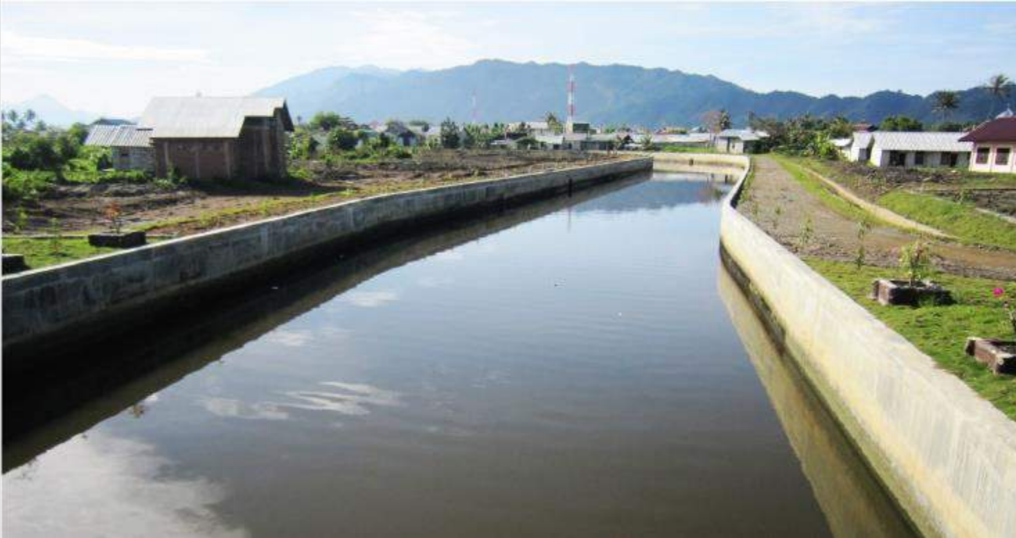
Pasangan Beton Bertulang pada Drainase Primer Kota Banda Aceh (2011) Kota Banda Aceh, Aceh
