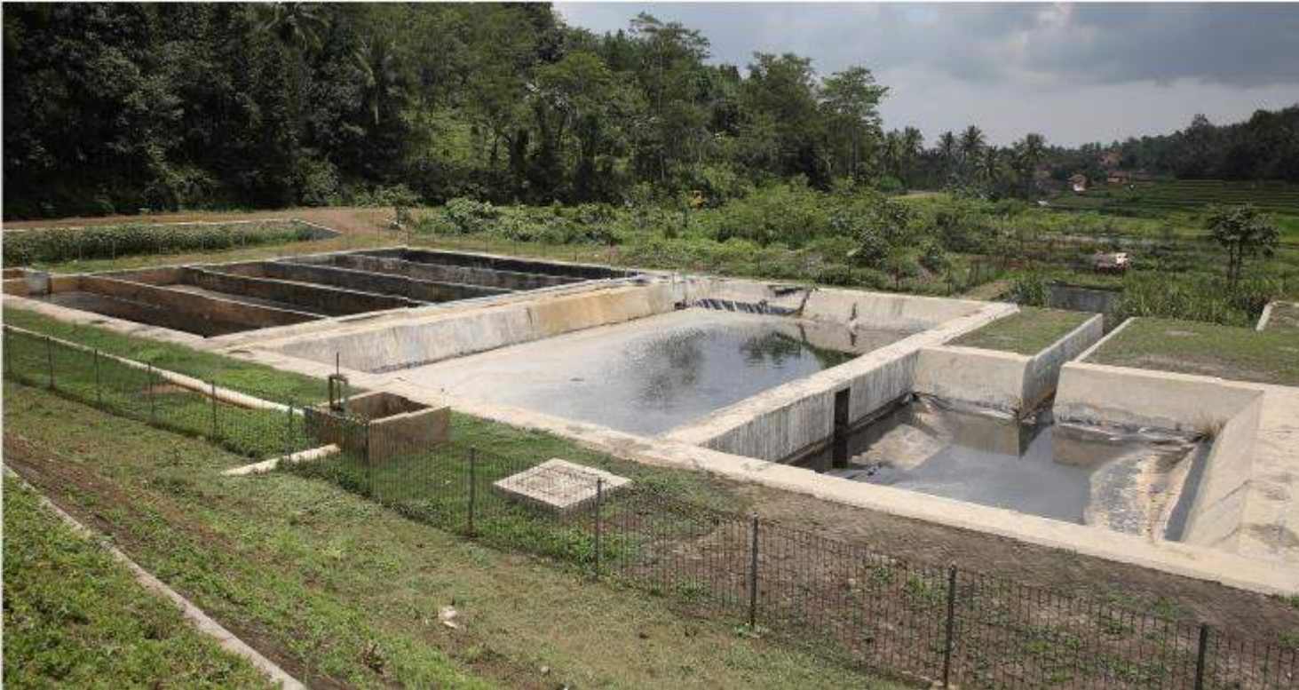
Pembangunan Bangunan Pengolahan Instalasi Pengolahan Air Lindi pada TPA
