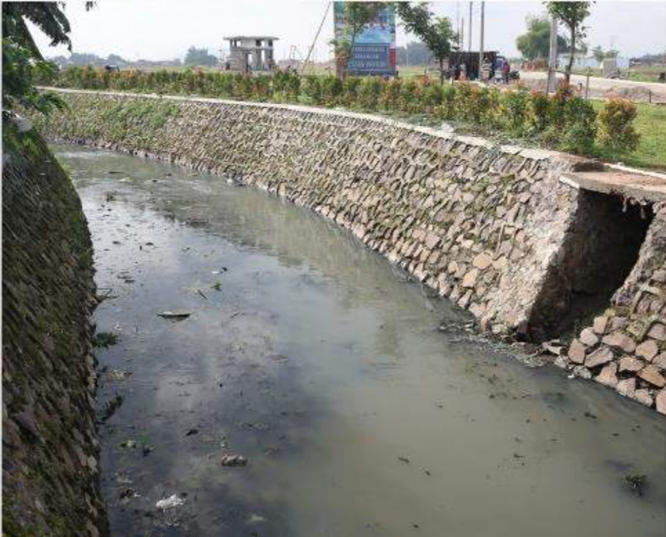
Pasangan Batu Kali pada Drainase Perkotaan
