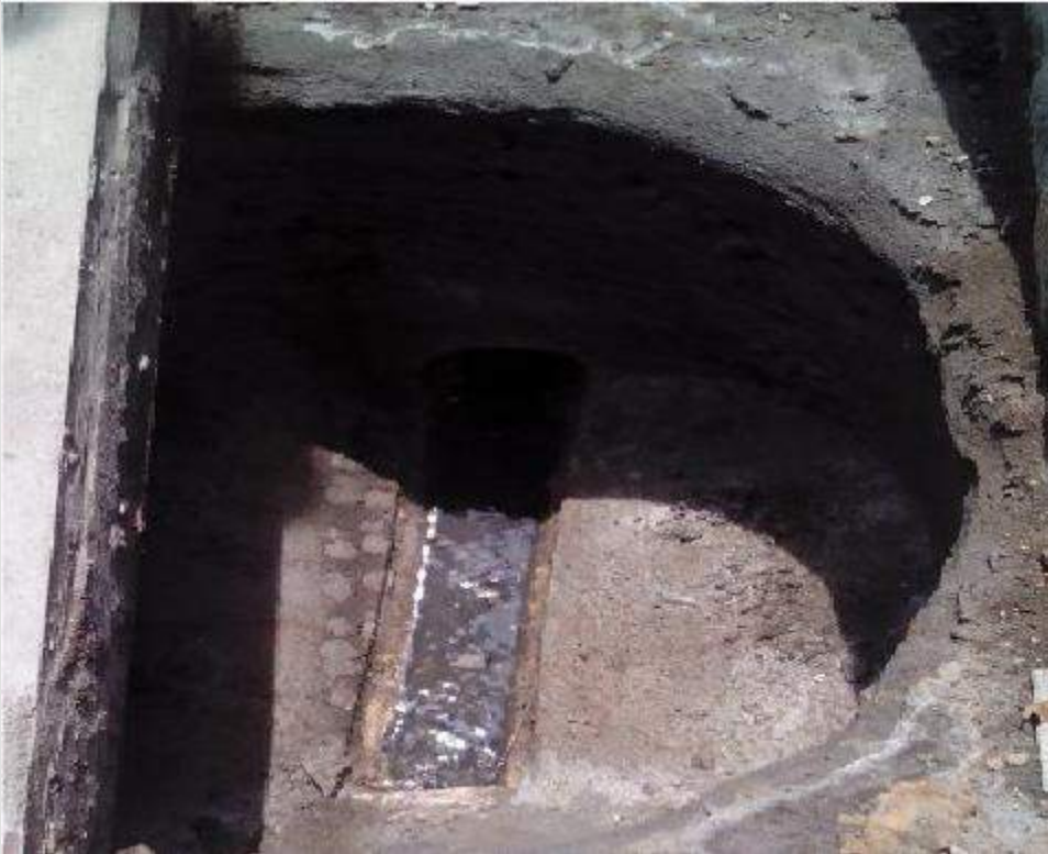
Pembangunan Bak Kontrol pada Jaringan Perpipaan Air Limbah
