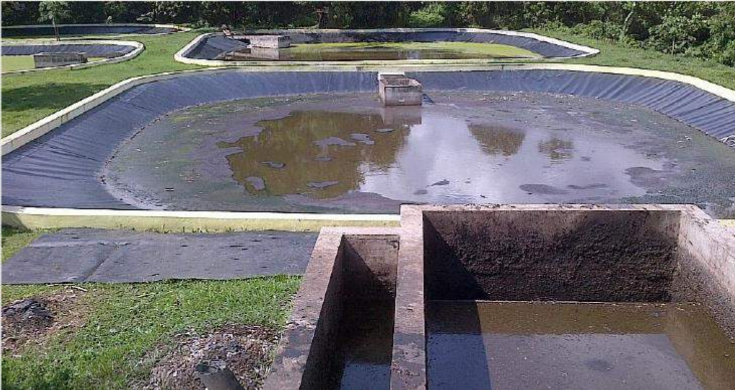
Pembangunan Kolam Pengolahan pada IPLT
