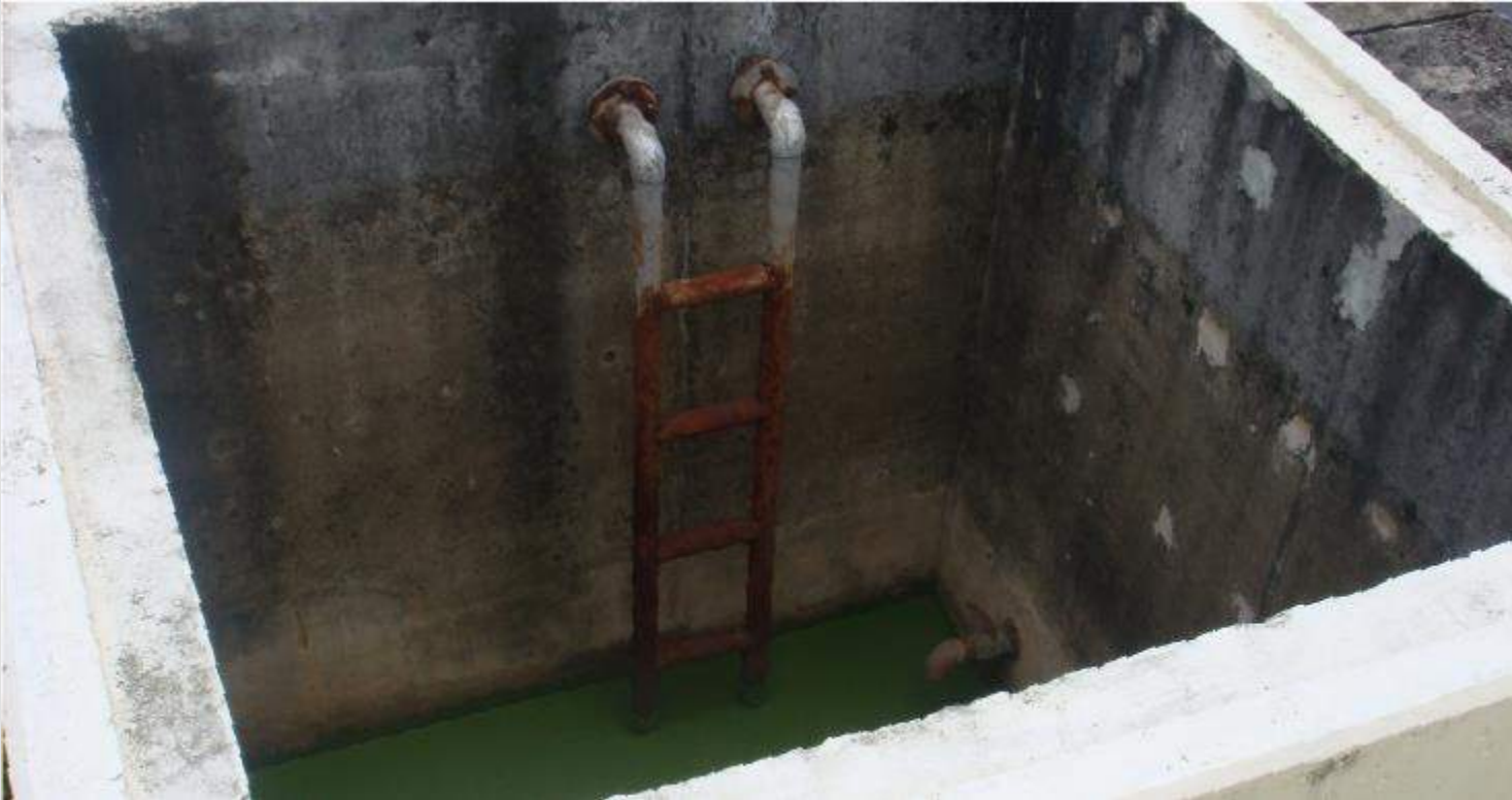
Pembangunan Bak Pengumpul pada PS Air Limbah Terpusat
