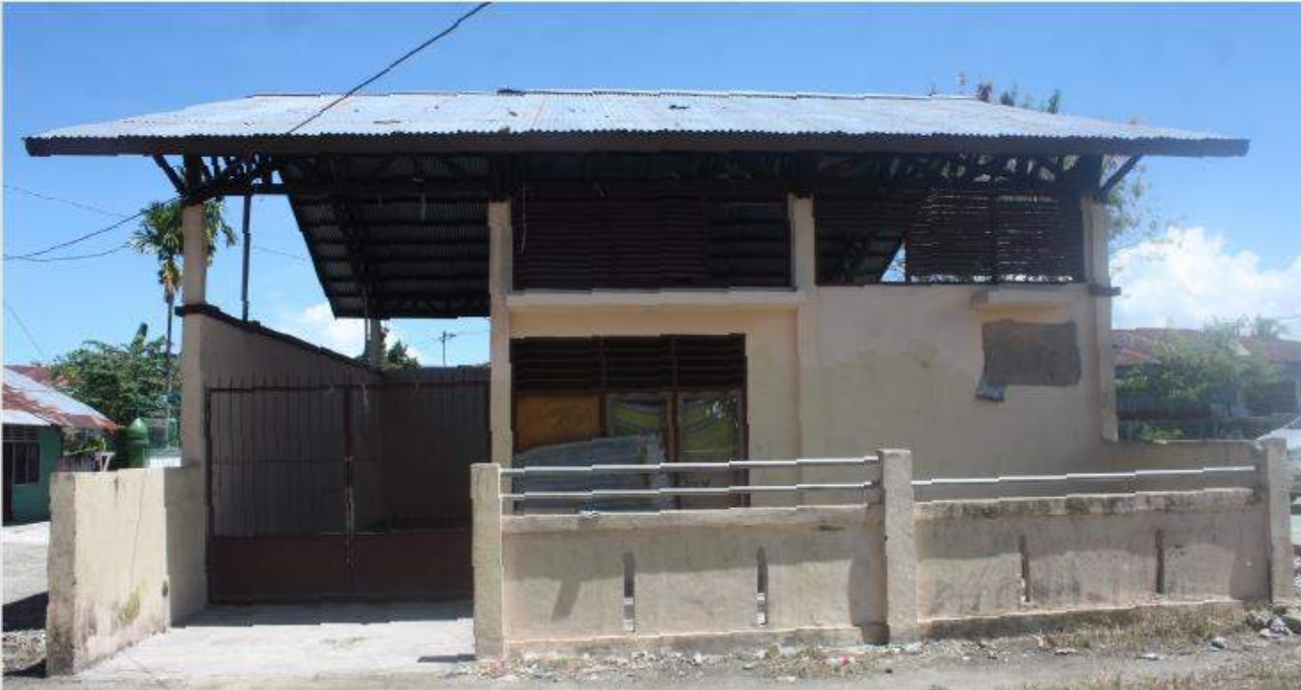
Pembangunan Area Penerimaan pada TPS 3R
