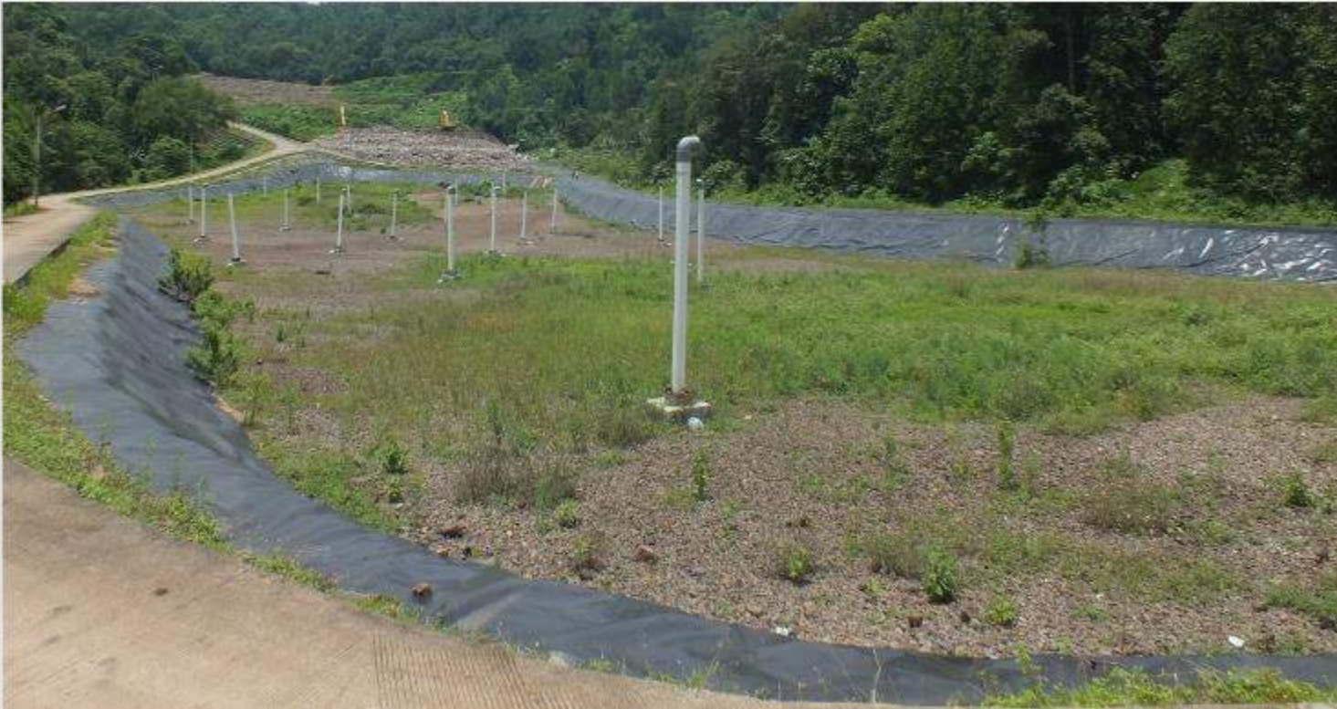
Pembangunan Lapisan Geomembran pada TPA Cilowong Kabupaten Serang, Banten
