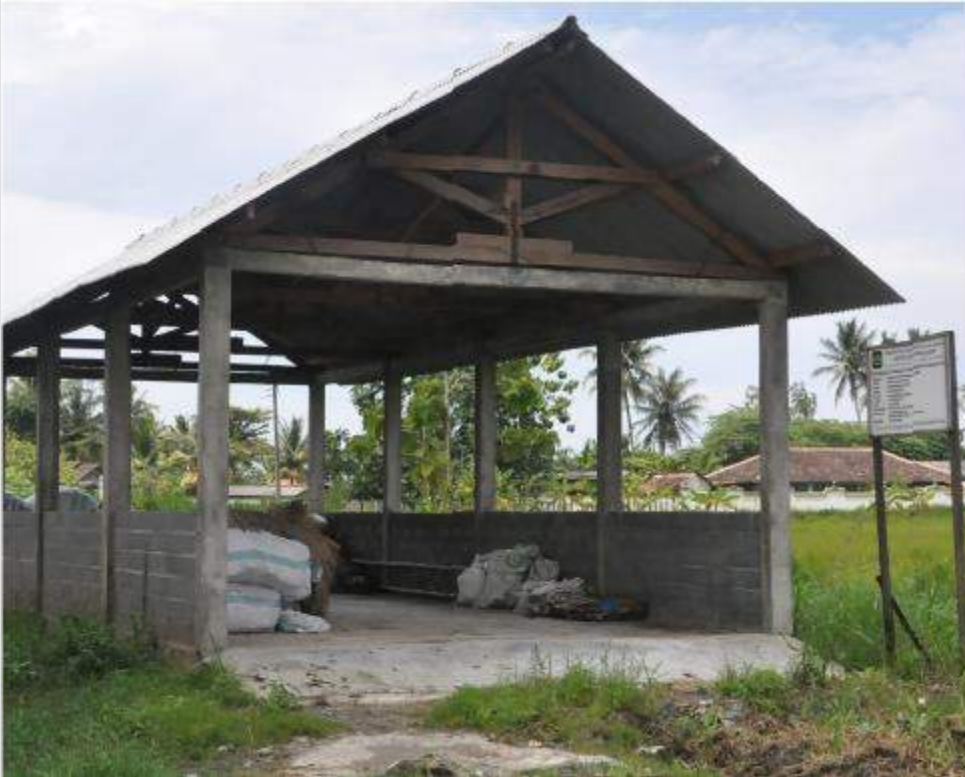
Pembangunan Gudang pada TPS 3R
