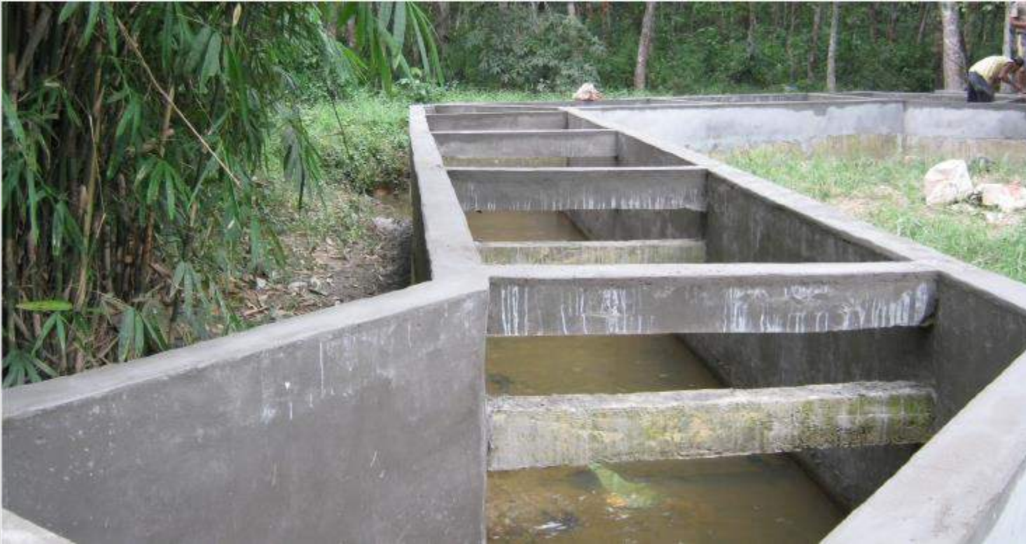
Pasangan Beton Bertulang pada Drainase Primer
