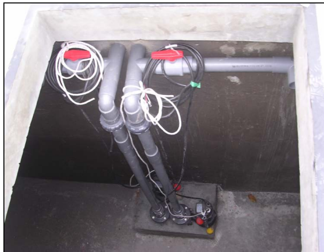
Gambar 3.15 : Contoh Pemasangan Pompa Celup Untuk IPAL.
