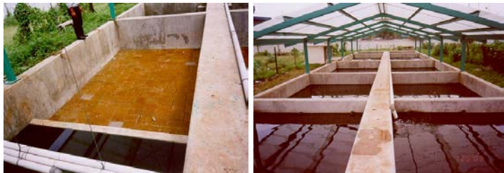
Gambar 3.22 : Reaktor Biofilter Anaerob Dari Bahan Beton Bertulang.
