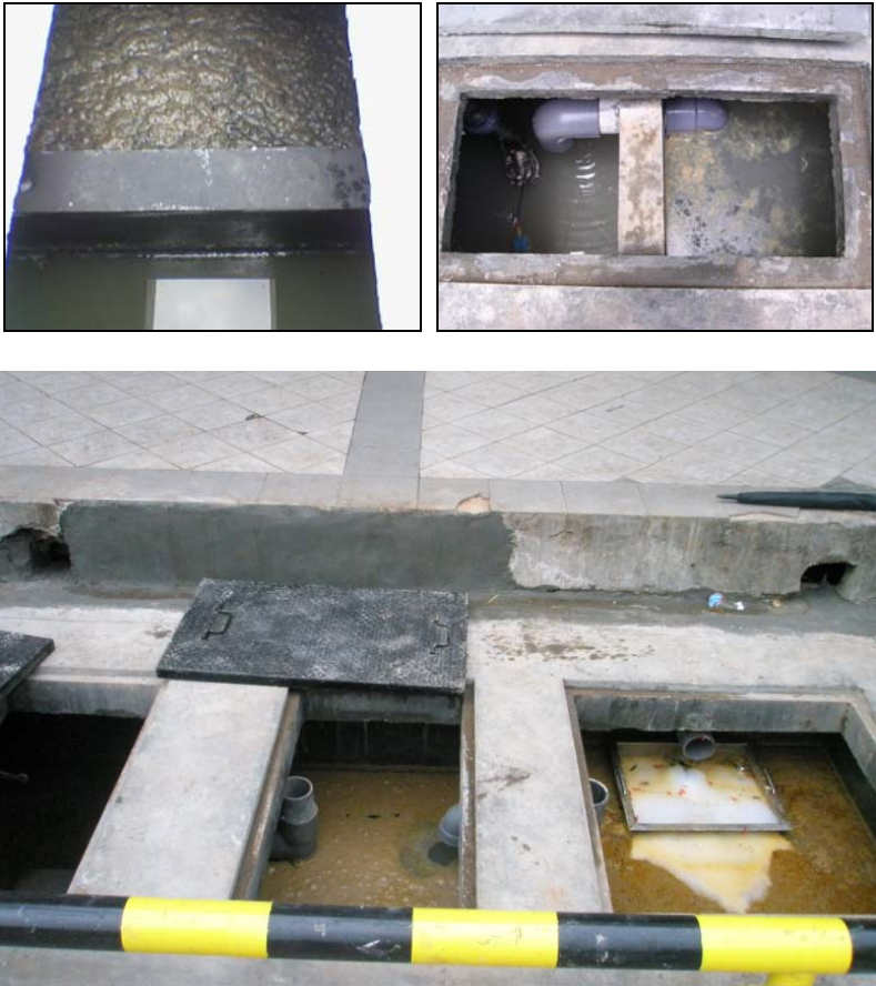
Gambar 3.6 : Contoh Konstruksi Bak Pemisah Lemak Sederhana.
