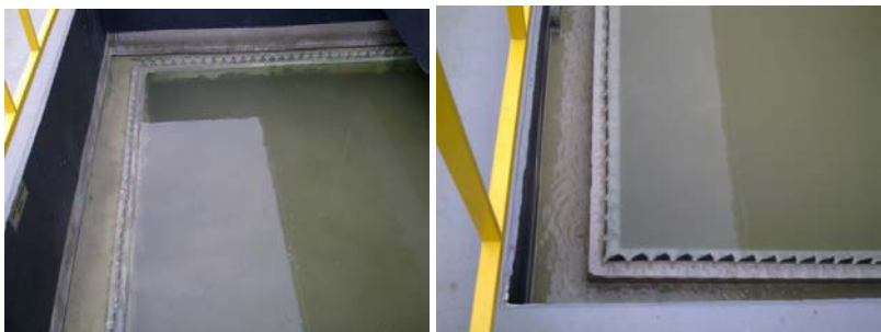
Gambar 3.19 : Contoh Bak Pengendap Bentuk Segi Empat.
