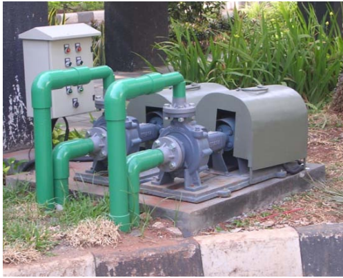
Gambar 3.17 : Contoh Pemasangan Pompa Centrifugal Untuk IPAL.
