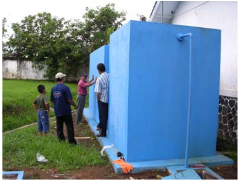
Gambar 3.20 : Reaktor Biofilter Anaerob dari Bahan FRP yang dilapis dengan Beton Cor.
