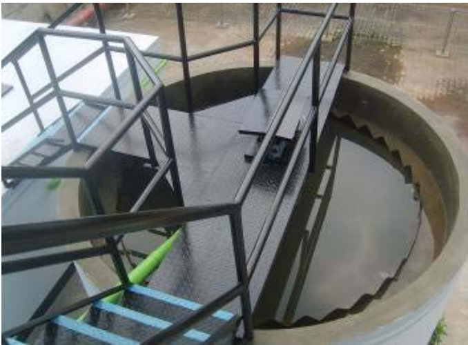
Gambar 3.18 : Contoh Bak Pengendap Bentuk Bulat.
