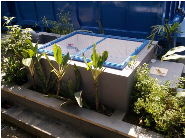
Gambar 3.33 : Salah Satu Contoh Bak Biokontrol.
