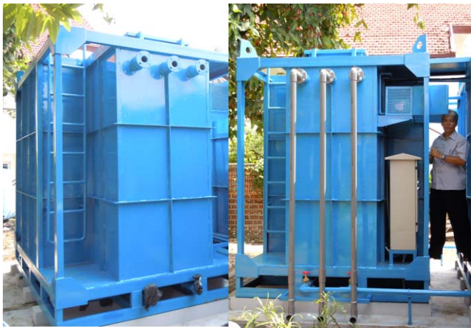
Gambar 3.8 : Contoh Disain Bak Pemisah Lemak dan Bak Ekualisasi Dari bahan Plat Baja.
