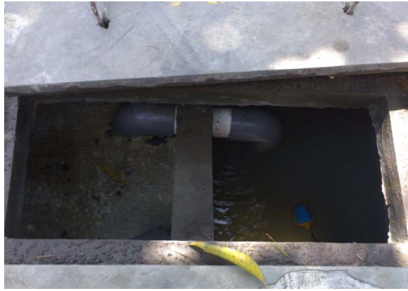
Gambar 3.4 : Photo Tipikal Bak Pengumpul Air Limbah.
