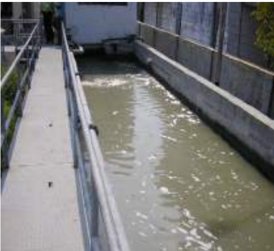
Gambar 3.12 : Contoh Bak Ekualisasi Terbuka Dari Bahan Beton Bertulang.
