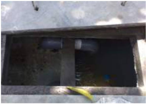
Gambar 3.4 : Photo Tipikal Bak Pengumpul Air Limbah.
