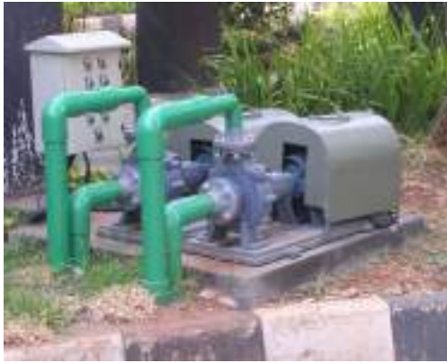
Gambar 3.17 : Contoh Pemasangan Pompa Centrifugal Untuk IPAL.
