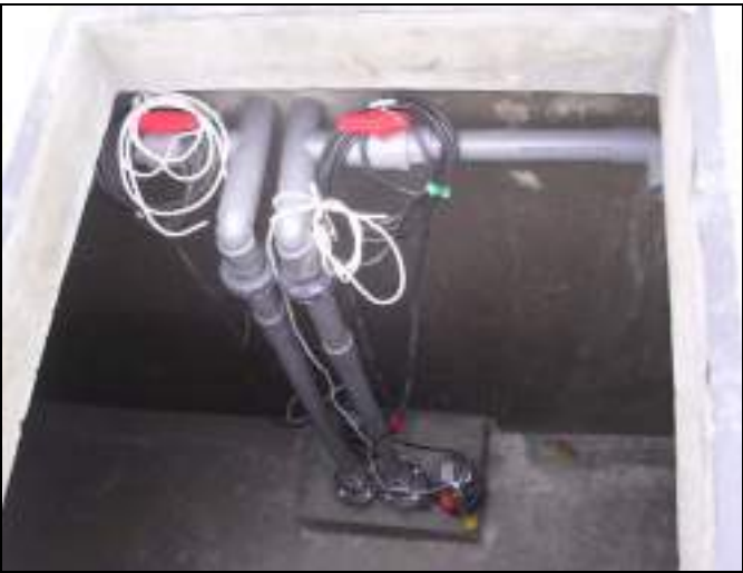
Gambar 3.15 : Contoh Pemasangan Pompa Celup Untuk IPAL.
