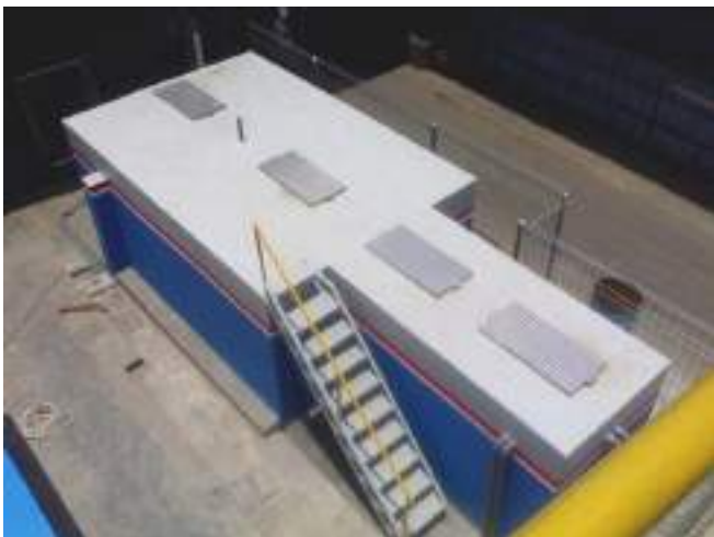
Gambar 3.11 : Contoh Bak pemisah Lemak dan Bak Ekualisasi Dari Bahan Beton Bertulang. (Kapasitas 60 M 3 Per Hari)
