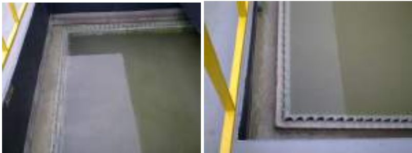
Gambar 3.19 : Contoh Bak Pengendap Bentuk Segi Empat.
