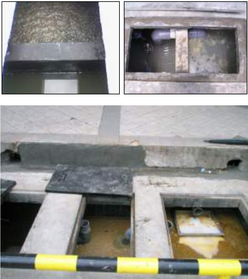
Gambar 3.6 : Contoh Konstruksi Bak Pemisah Lemak Sederhana.
