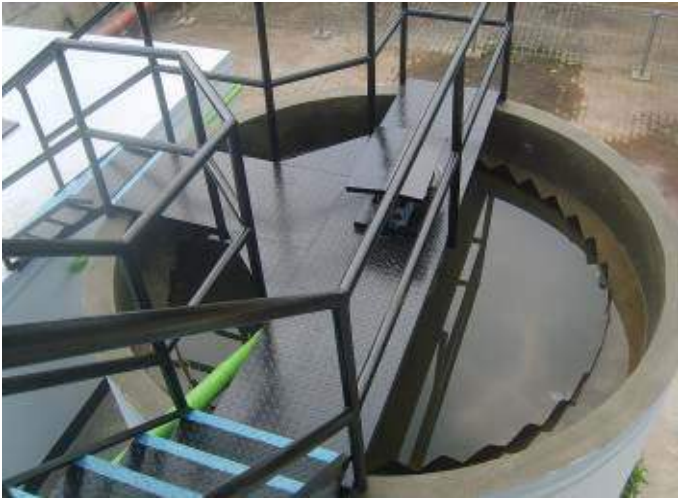
Gambar 3.18 : Contoh Bak Pengendap Bentuk Bulat.
