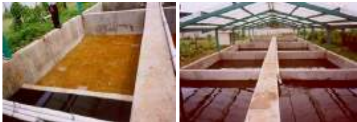
Gambar 3.22 : Reaktor Biofilter Anaerob Dari Bahan Beton Bertulang.
