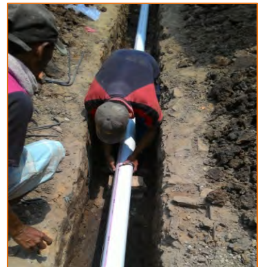
Gambar 10: Pemasangan Pipa Air Limbah.
