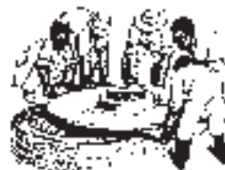
Pasang tutup sumur di tempatnya.
