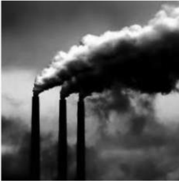
Gambar 5. Industri pengolahan logam menyebarkan polutan udara melalui cerobong asap. 23
