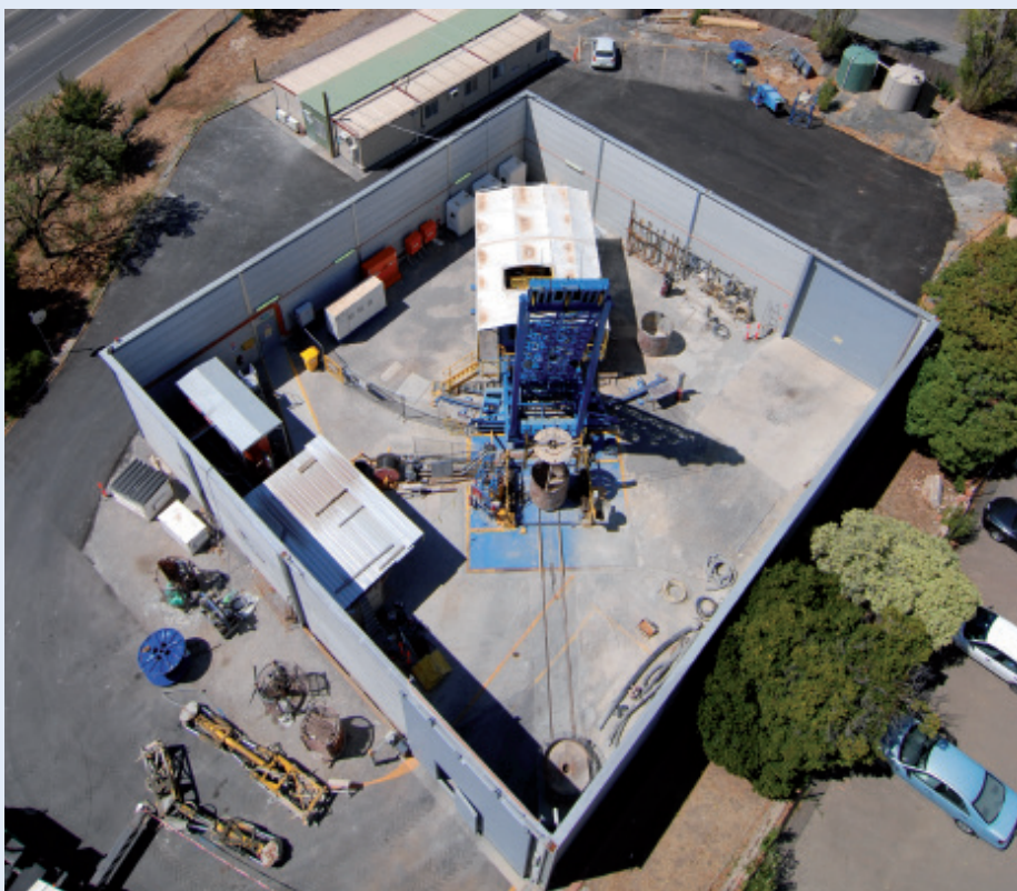
Tampak atas dari lokasi kerja di Ballarat. Sumber: Ladang Emas LGL-Ballarat.
