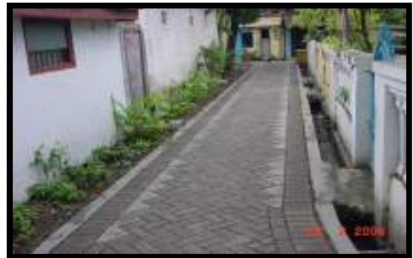
Kondisi Awal Kampung Rungkut
